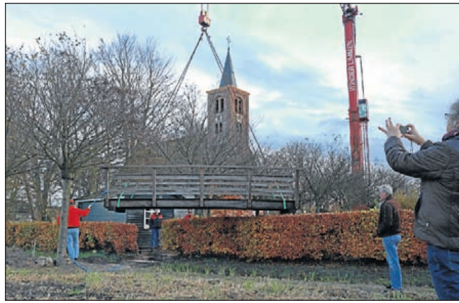
De 'nieuwe' voetgangersbrug voor de Hortus, die met een kraan van de firma Winder op z'n plaats wordt gehesen; op de achtergrond het hervormde Limmer kerkje. Foto Peter van Renen.
