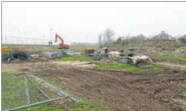
Na de herinrichting van het sportpark wordt de grond van de veertien kavels bouwrijp gemaakt.
