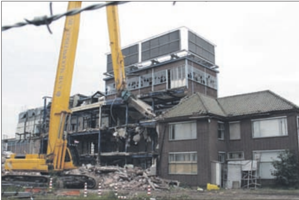
De sloop van de HMS-fabriek is verleden week gestart.
