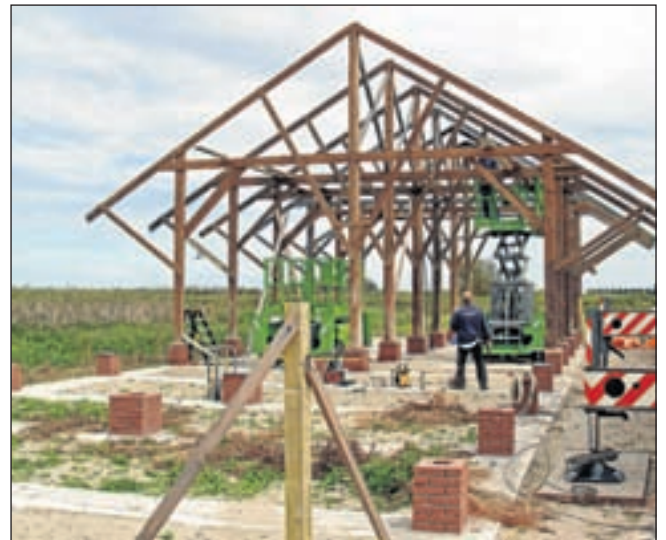
Het plaatsen en stellen van de gebinten is een precies werkje. Na drie dagen stonden alle elf gebinten op hun plaats.
