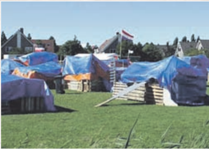
Vanwege het slechte weer bleven de timmerbouwwerken de gehele week onder de blauwe zeilen.
