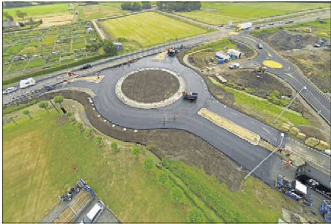
Op de foto: de aanleg van de rotonde van bovenaf gezien. De tweede rotonde aan de rechterzijde is een tijdelijke.
