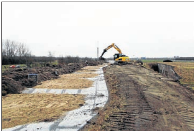
Het dak met bitumenafdeklaag wordt afgedekt met zand (foto: Johan Graas)
