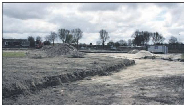
Bouwrijp maken De Dije: Het bouwrijp maken van de kavels is in volle gang (foto: gemeente Uitgeest)
