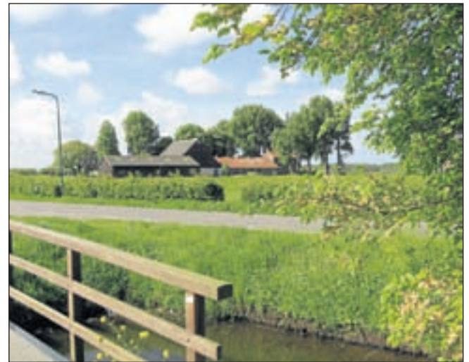
De voormalige boerderij van Brandjes wordt momenteel gerenoveerd. Als de plannen doorgaan komt de oostelijke randweg voor de voormalige boerderij te liggen en zal er bij het Cronenburgerlaantje een uitvalsweg komen. (foto Ernst Mooij).
