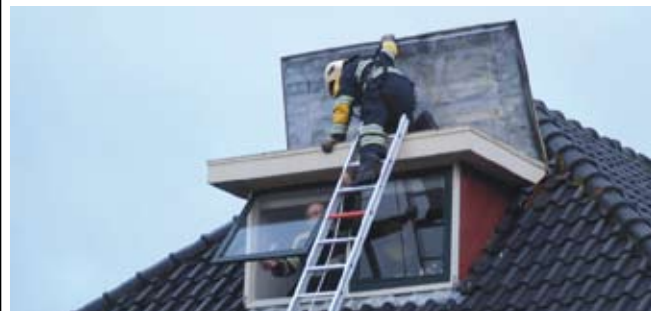
Zondagmiddag is de brandweer ruim een uur bezig geweest met het veiligstellen van een zinken dak dat op de Dorpsstraat van een woning dreigde te waaien.
