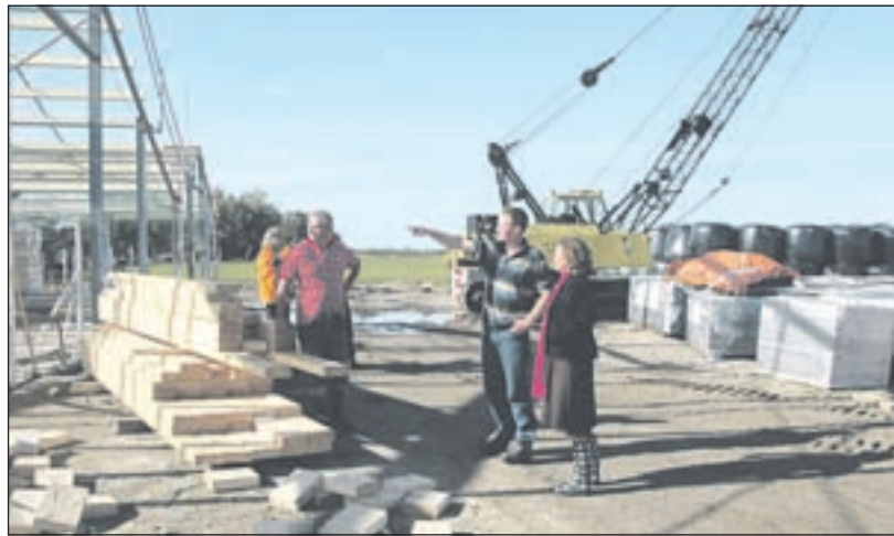
Melkveehouder Dick Hos toont wethouder Christel Portegies de nieuwe stal in aanbouw.
