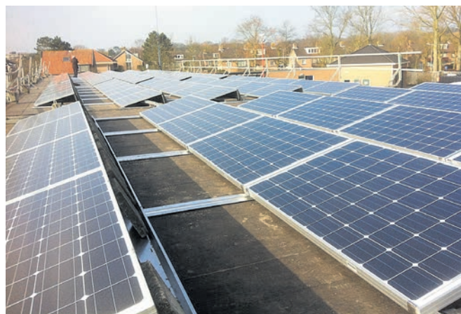
Zonnecentrale met panelen van een groep bewoners op een dak van de Schulpstet in kern Castricum
