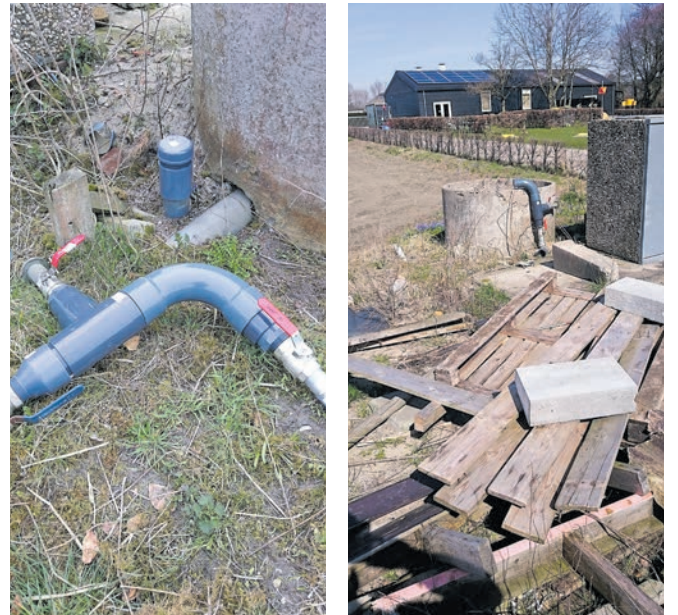
Nieuw aangeschafte kogelkranen met buisconstructie bij de oude pompplaats (foto's: aangeleverd)
