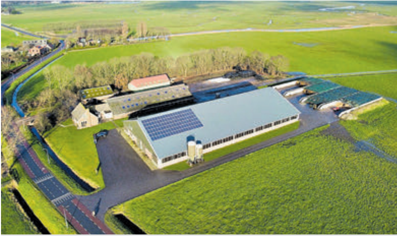
Op het staldak is nog veel ruimte voor extra zonnepanelen; binnenkort worden die geplaatst. Foto: Wim Schermer
