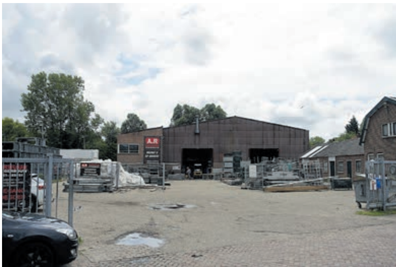
De bouwlocatie Brakersweg 19-21. Archiefphoto: Hans Boot
