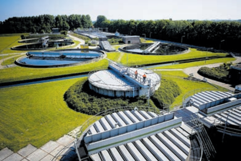
De rioolwaterzuivering in Beemster wordt gerenoveerd in 2021. Foto: HHNK
