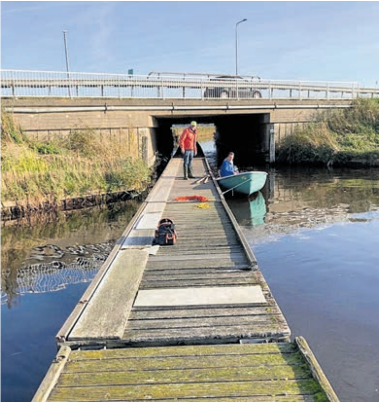
De vlonder wordt in de komende weken opgeknapt. Foto: aangeleverd
