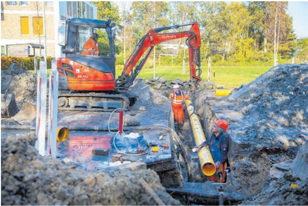
Stedin vervangt momenteel de oude gietijzeren gasleidingen voor kunststof leidingen
