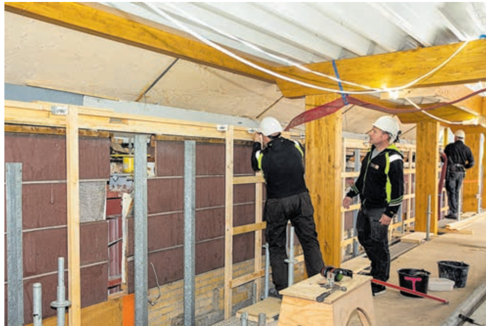
Boven de hoofden van het winkelend publiek zijn werklui bezig raamkozijnen aan te brengen. In dit deel is het nieuwe dak al aangebracht en is de gele metalen draagconstructie vervangen door houten staanders
