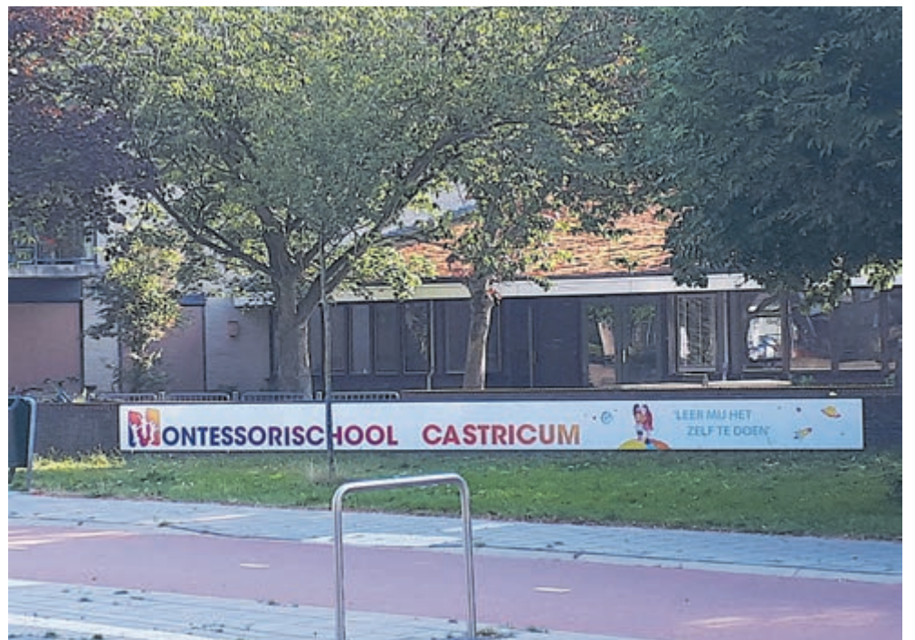
Het pand werd twintig jaar geleden gebouwd en is het eerste duurzame schoolgebouw van Nederland. Foto: aangeleverd:
