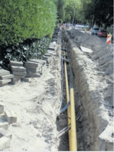
Het leggen van het nieuwe gasbuissegment in de sleuf. Foto: Wilhelm Carton
