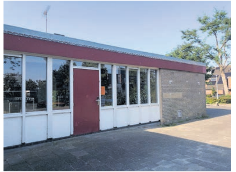
De gymzaal bij de Rembrandtschool. Foto: aangeleverd
