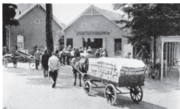
Veilinggebouw in de Dorpsstraat
