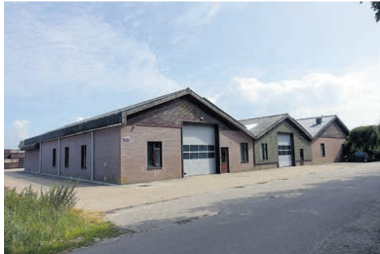
De te slopen loodsen.
