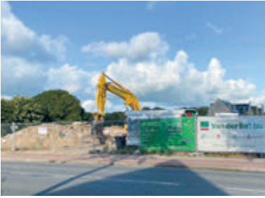
► Op 16 juli zijn de laatste resten gesloopt. Foto: Jeppe Hoogland
