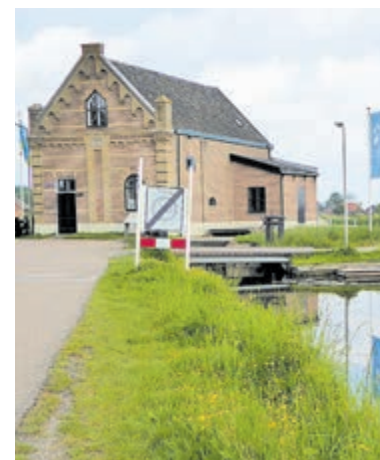
Het Museumgemaal Akersloot. Foto: Stichting Oer-IJ
