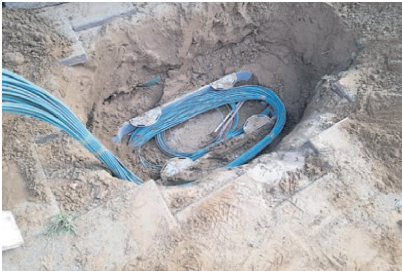
Het aanleggen leggen van een glasvezelnetwerk in de grond. Foto: Bos Media Services
