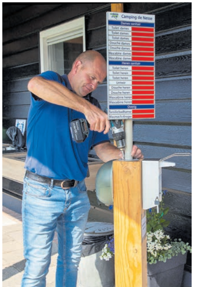
Het sanitair mag weer open. John Adrichem bevestigt nog snel het aan-/afwezigheidsbordje. (Foto: Henk de Reus)
