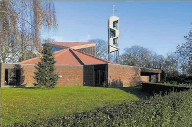
De klokken werden vanwege de hoge kosten niet in de kerk zelf verwerkt, maar in een separate klokkentoren. Foto: aangeleverd
