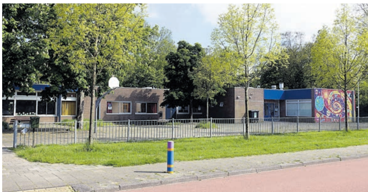
De locatie die nu bestemd is voor woningbouw. Foto: Hans Boot
