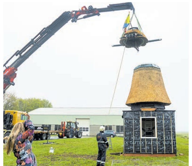
Een bijzonder moment als de kap met een kraan op het lijf van de molen wordt geplaatst. Foto: Henk de Reus
