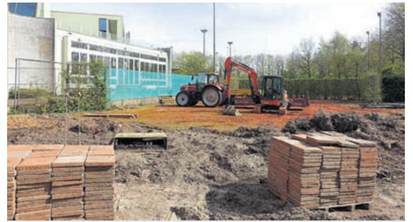
Het bouwrijp maken is in volle gang. Foto: Hans Boot
