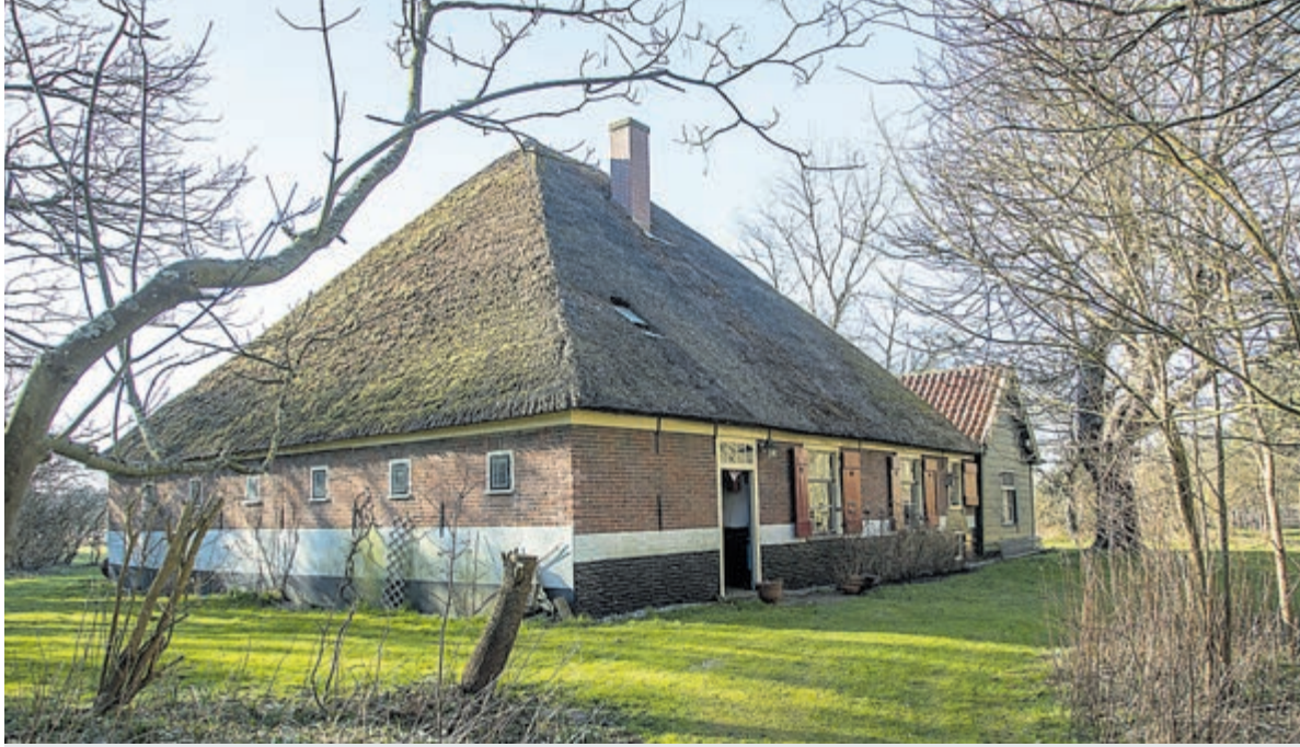
De voorgevel van boerderij Berwout vanaf de zuidoosthoek gezien. Het exterieur van de stolpboerderij is sinds de bouw (1866-1869) vrijwel intact gebleven. Foto: Henk de Reus
