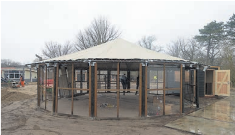
De voorlopige horecavoorziening in aanbouw. Foto: Hans Boot
