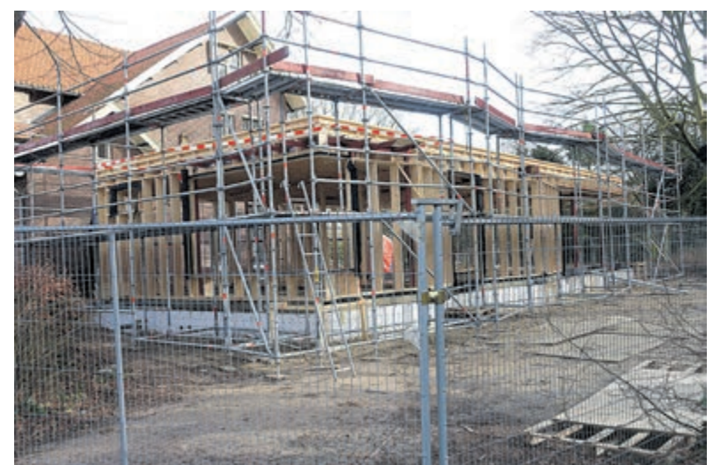
De aanbouw aan de oostzijde, waarin ook een appartement wordt gerealiseerd.
