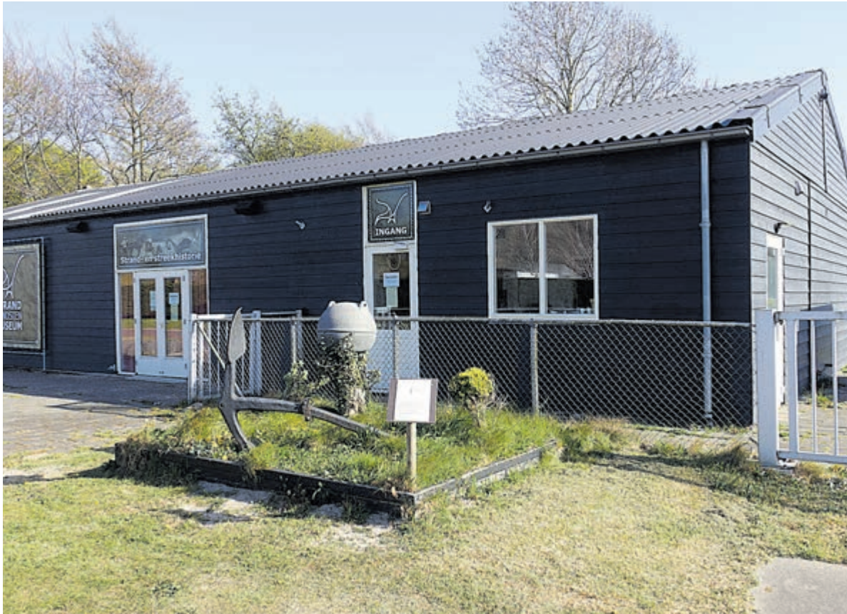
Het Strandvondstenmuseum dat in oktober 2020 zijn deuren sloot. Archiefoto: Hans Boot
