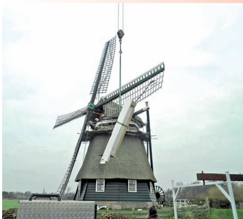
Het moment waarop de peluw met een hoogwerker op zijn plek wordt gehesen.
