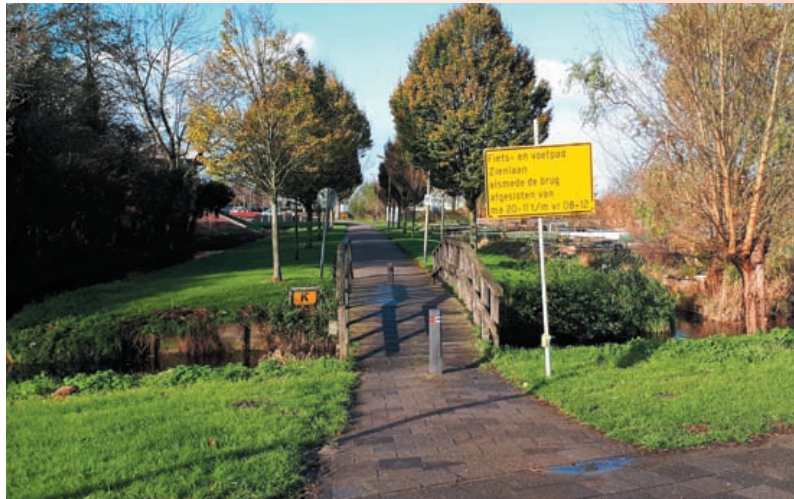
Het bruggetje van de Zienlaan naar de Geesterweg wordt vervangen door een bredere.
