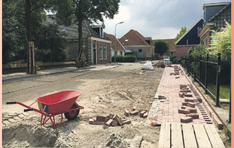
De werkzaamheden op de Langebuurt zijn, op de bestrating na, klaar (foto: gemeente Uitgeest).
