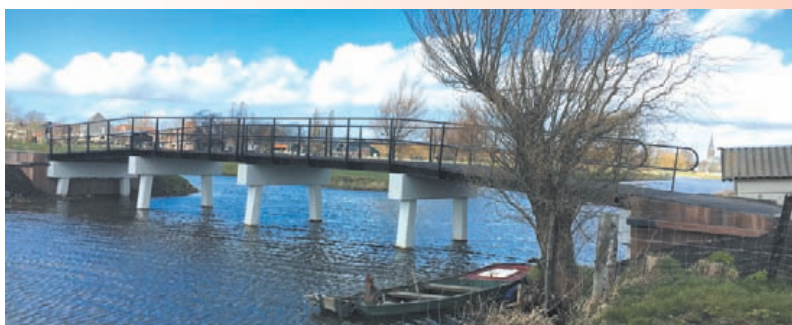
De gerenoveerde brug bij De Terp (foto: gemeente Uitgeest)
