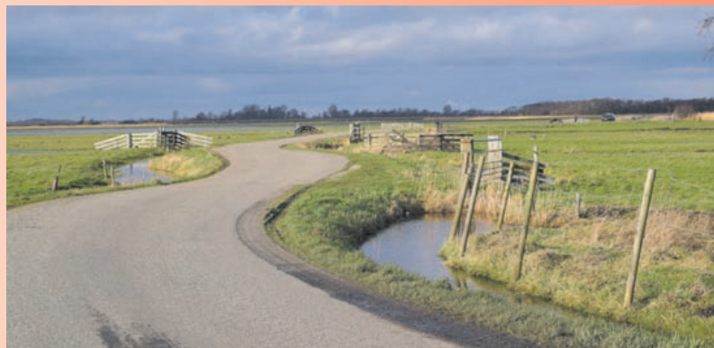
Op dit deel van de Lagendijk vinden donderdag werkzaamheden plaats, waardoor de weg moet worden afgesloten voor weggebruikers.
