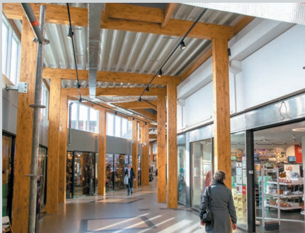
▲ Bijna klaar op plafondplaten na en over bestaande tegelvloer komt nog slijtvaste gietvloer.
